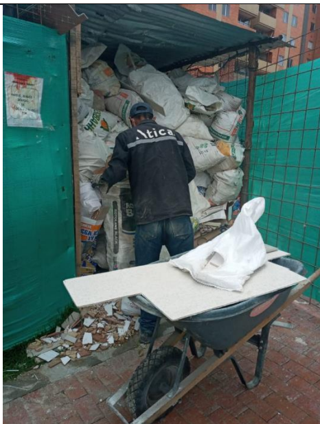
Recolección RCD conjunto residencial Provenzal
