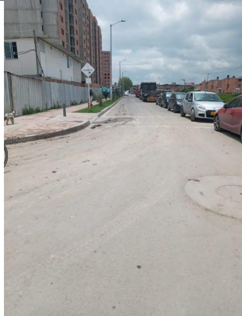
Problemática salida de las obras.
