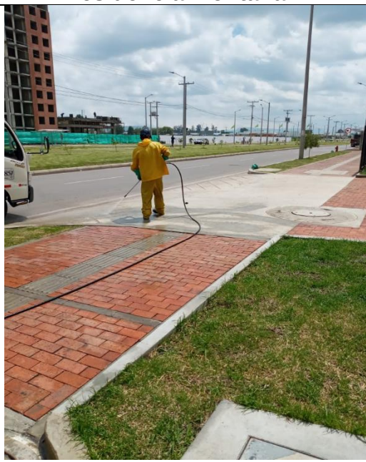
Lavado y desinfección de par vial carrera 24
